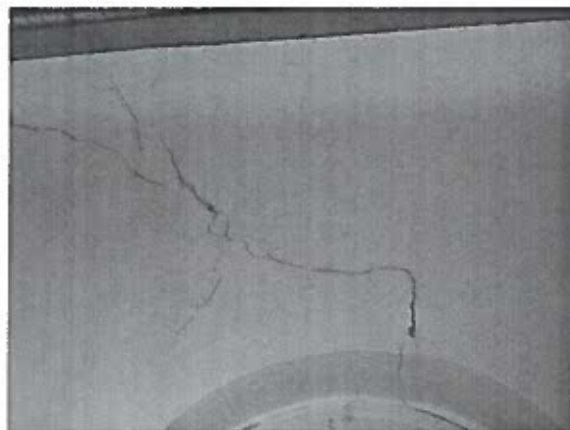
Foto. 3. Trhliny v klenbovom okennom preklade - interiér.
