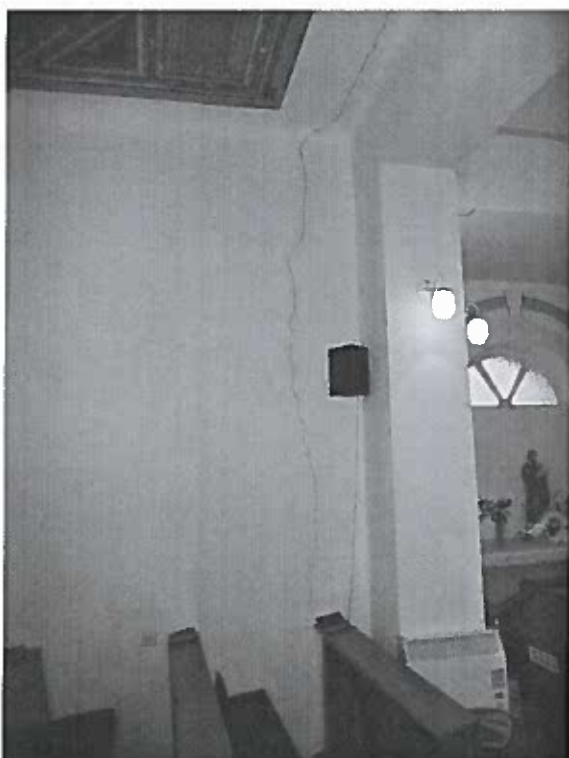
Foto. 4. Trhlina pri pristavovanej časti kaplnky prechádzajúca do stropu.
