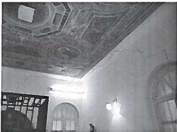
Foto. 2. Trhliny na južnej a západnej obvodovej stene kaplnky.
