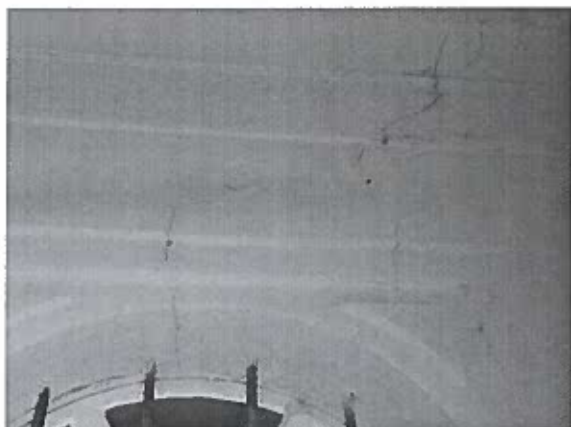
Foto. 6. Trhliny v klenbovom okennom preklade - exteriér.
